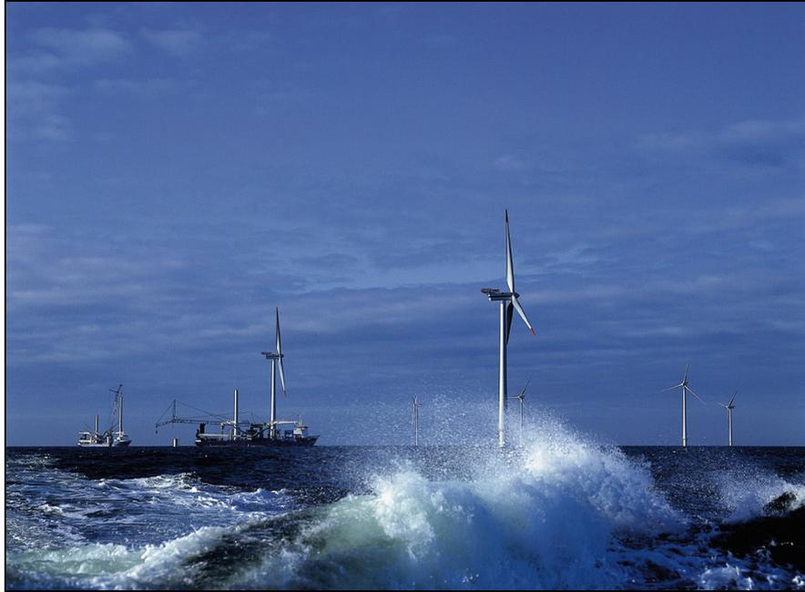
Abb. 1: Montageschiffe beim Aufbau der Anlagen für den dänischen Offshore-Windpark Horns Rev in der Nordsee (© Vestas Central Europe)
